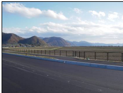
図-6 転落防止柵
