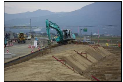
図-9 ランディング 施工状況
