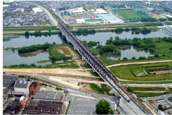
図-1 加古川 樹木の繁茂状況
