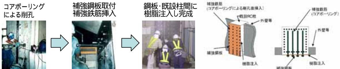
図-4 一面耐震補強工法のイメージ
