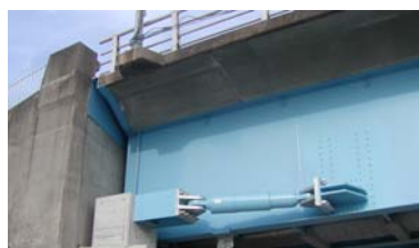
図-4.5 ダンパーによる慣性力分散工法施工要領図
