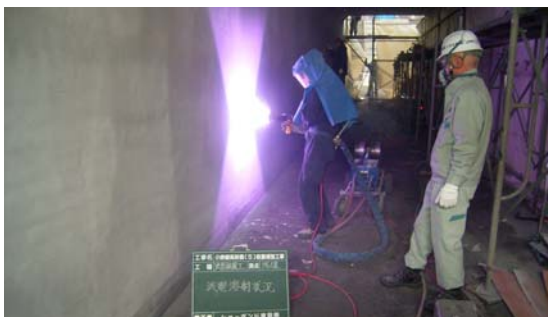
写真-4 溶射状況
