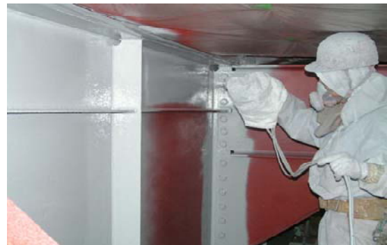
写真－4 「高塗着スプレー施工状況」
