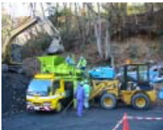
写真 - 1 甲府河川国道事務所管内の分別作業
