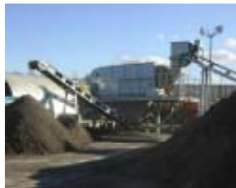
写真 - 2 宇都宮国道事務所管内の業者保有分別機
