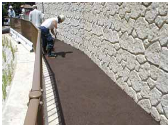
写真 - 2 施工状況
