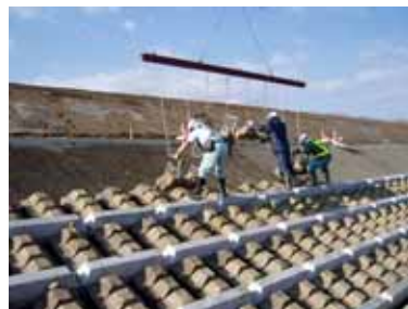
連節ブロック張施工
