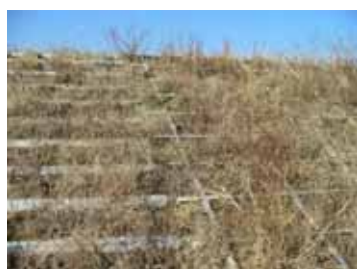
発生ブロック再利用工法
