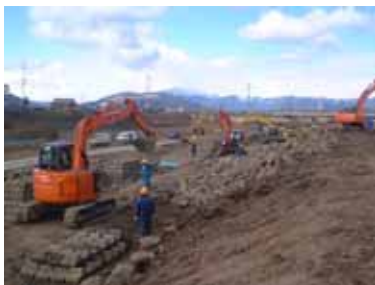
ブロック撤去状況
