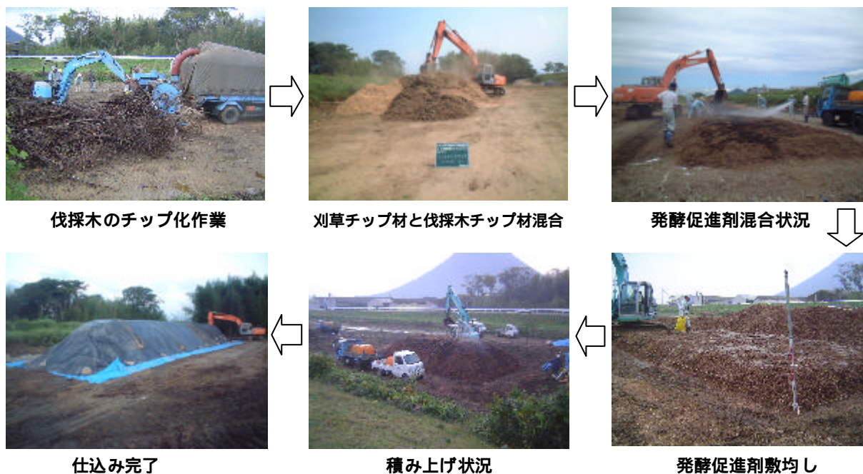
図 - 1 堆肥仕込みまでの施工手順
