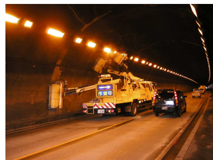
写真① トンネル清掃
