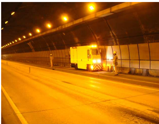
写真④根之谷トンネル清掃試験状況
