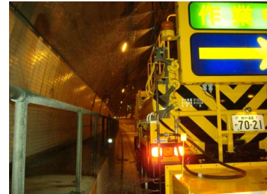
写真 - 10 散水車による洗浄
