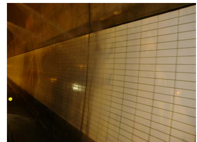
写真 - 12 散水車による洗浄状況
