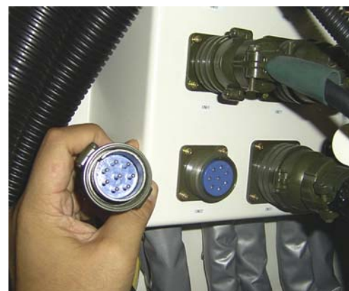
写真7 配線のコネクタ接続
