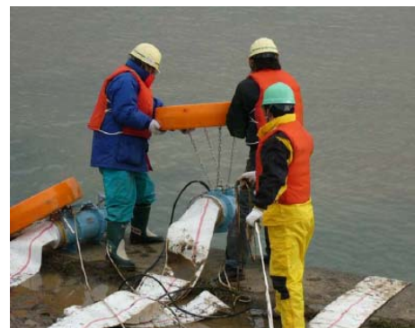
写真6 排水ポンプの人力設営
