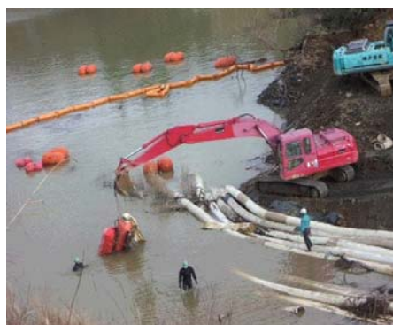
写真2 排水ポンプ設営
