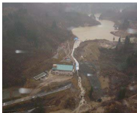
写真1 芋川河道閉塞排水
