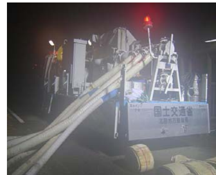
写真3 夜間排水作業
