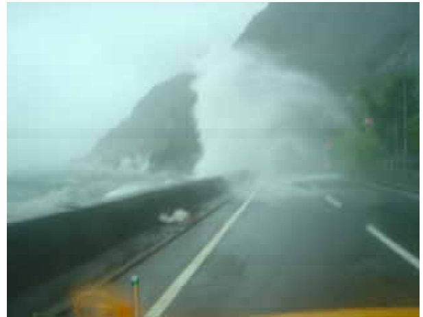
写真 - 2 越波状況（鹿児島市吉野町）
