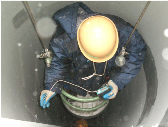
写真2．作業用通路昇降状況
