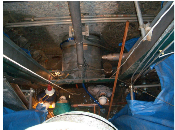
写真3．仮締切内作業状況
