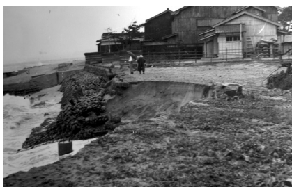
写真-1 皆生工区の海岸侵食(昭和30年)
