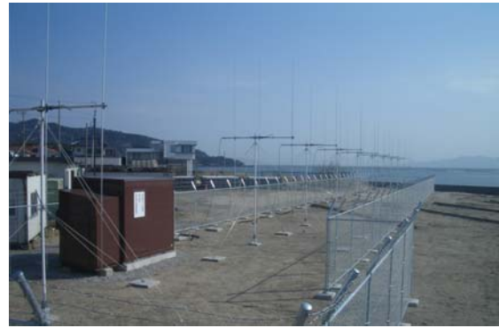
図-7 本格導入設置状況
