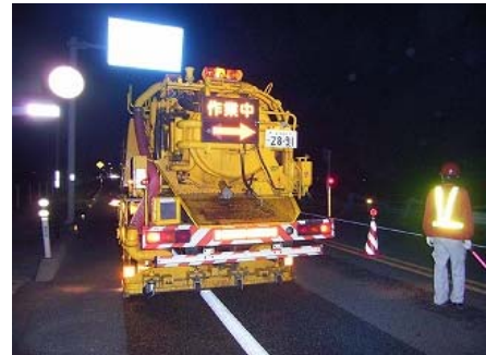
写真-1 排水性舗装清掃作業
