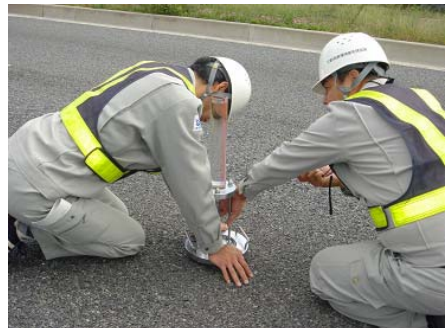
写真-2 現場透水量の測定
