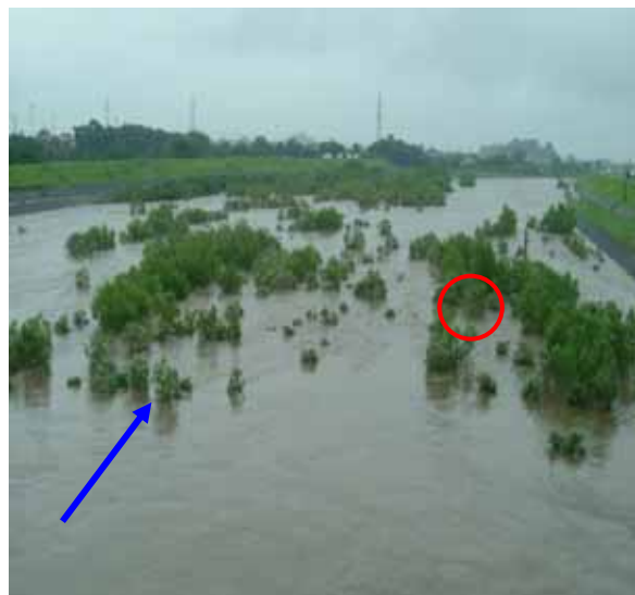
図3.9.1 出水時の状況 (赤丸印の箇所の水深約2m)
