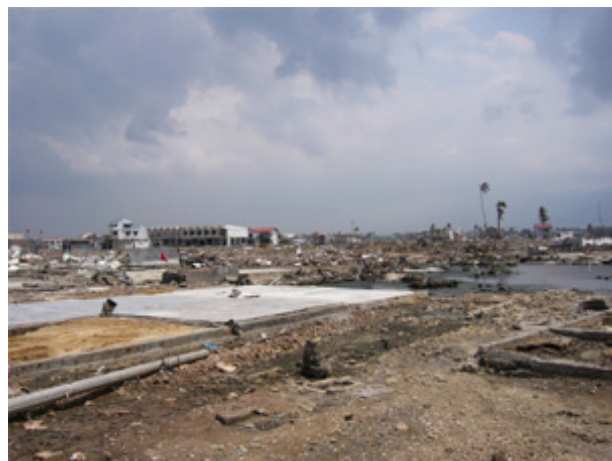
写真－1 バンダアチェにおける被害
