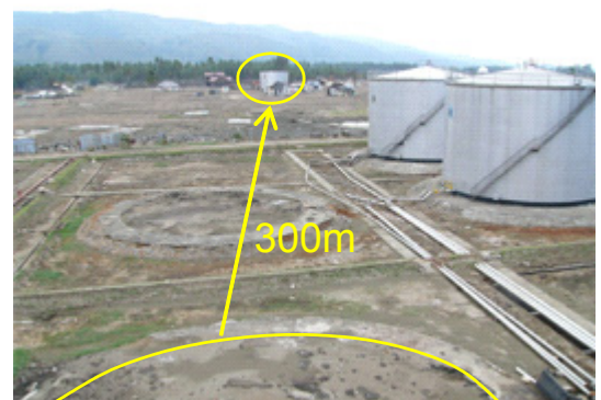
写真-5 オイルタンクの津波漂流
