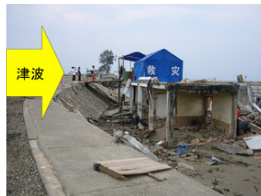
写真-7 盛土による津波被害の軽減
