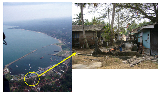
写真-8 漁港背後の津波被害の軽減
