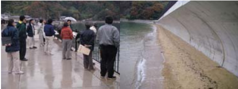
写真-5：大迫港現地視察状況
