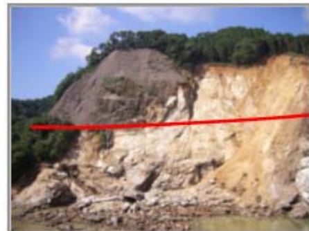
写真6 崩落した下流右岸町道(地点①)
