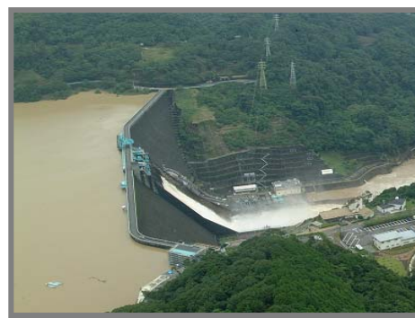
写真5 鶴田ダム貯水池の状況(23日)
