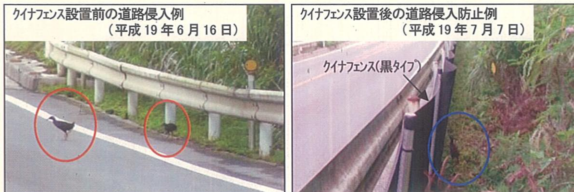
図 5 クイナフェンス設置前・設置後の侵入状況(C区間)
