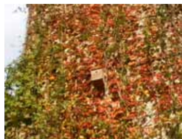
写真-4：橋脚巣箱
