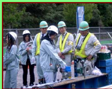
写真-8 レンによる橋桁のボルト締め
