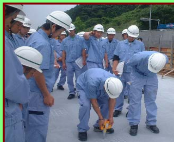
写真-6 シュミットマーによるコンクリート強度確認
