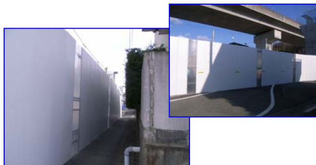
写真-12、13 住宅地周辺は、通常より狭い間隔でスリット（透明板）を設置
