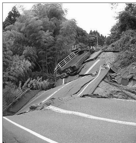
写真-1 被災した 国道8号長岡市大積千本町地先
