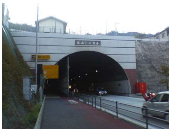
写真1 休山トンネル全景
