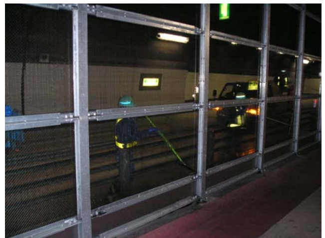
写真-4 人力清掃作業状況
