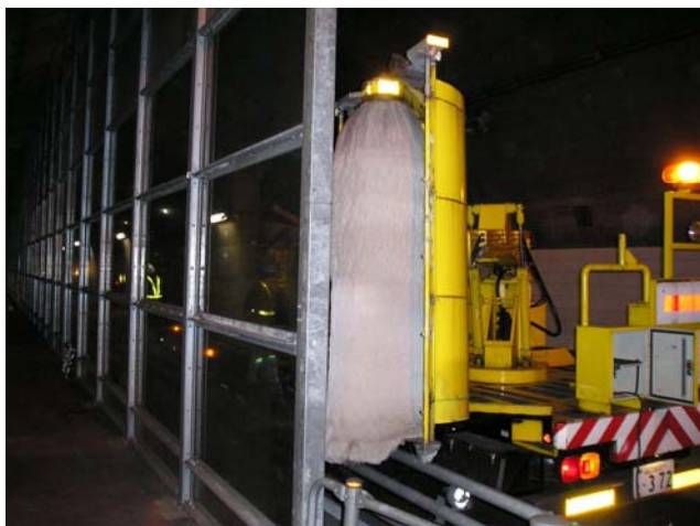
写真-3 トンネル清掃車作業状況
