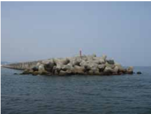
写真-1 消波ブロック被覆堤 (高知港)
