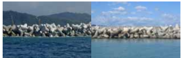
写真-2 消波ブロックの施工後(左)と荒天後(右)
