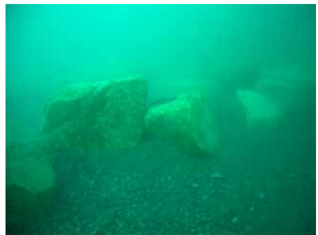
写真 - 6 マウンド捨石施工後
