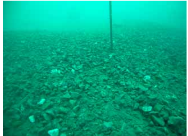
写真 - 5 フィルター施工後
