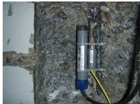
写真-2 モニタリング用照合電極
