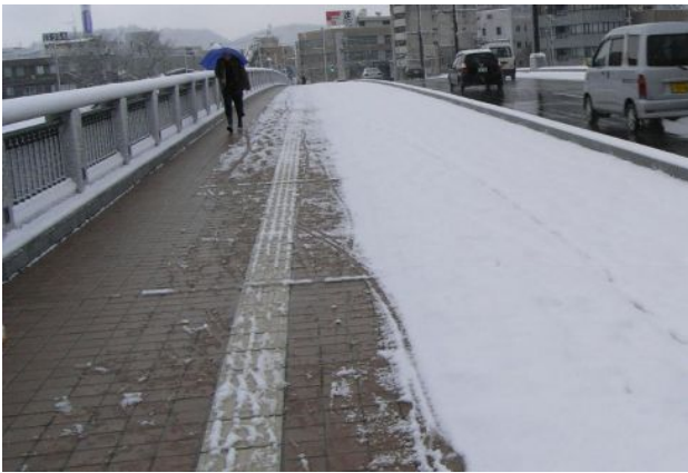
写真-6 鋼床版橋（幸橋）融雪状況（歩道, 車道）
