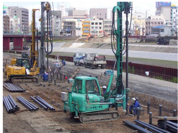
写真-3 専用熱交換杭の施工
