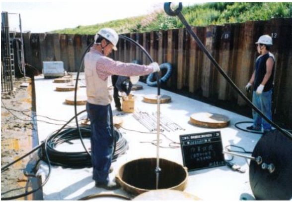
写真-2 鋼管基礎杭への送水ポリ管の設置
