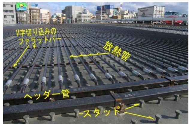
写真-5 鋼床版上での放熱管の施工
