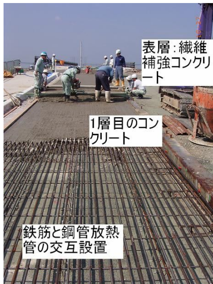
写真-4 連続鉄筋と放熱管，wet on wet の二層施工
