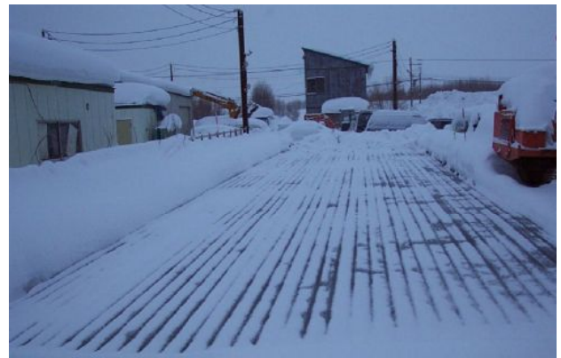
写真-8 札幌市内での融雪状況
