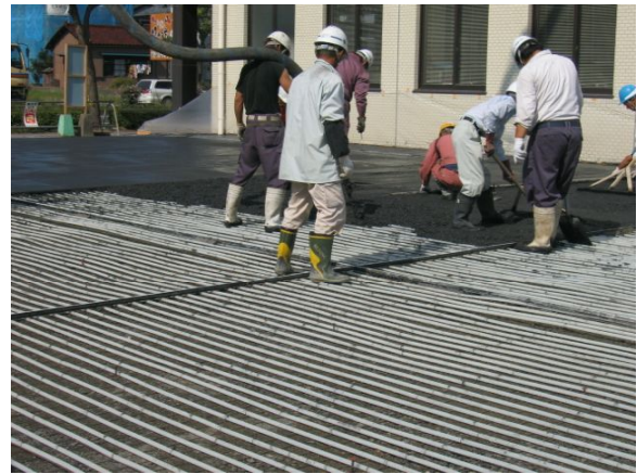
写真-7 アスファルト駐車場での放熱管設置と黒色薄層SFRCの施工
