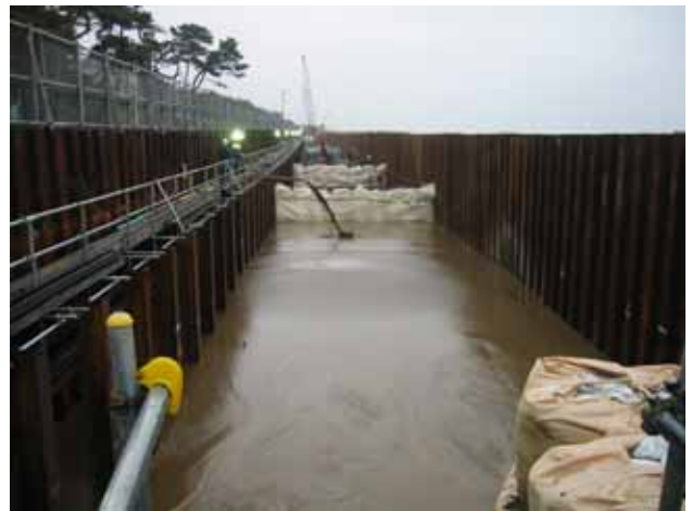
写真-6 流動化処理土打設状況
