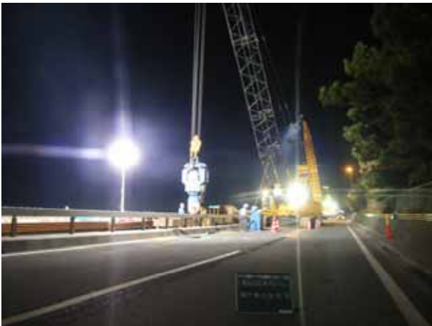
写真-2 鋼矢板打設状況
