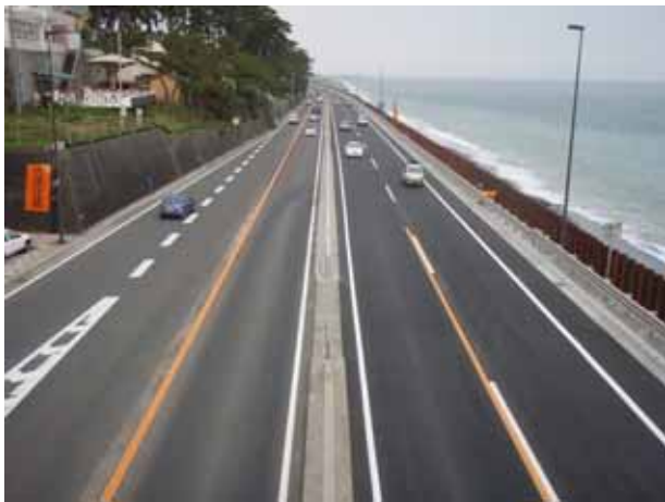
写真-7 暫定4車線供用状況
