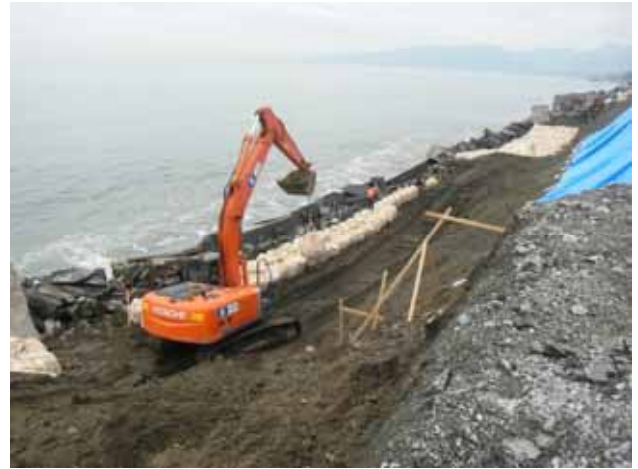
写真-3 土嚢設置状況
