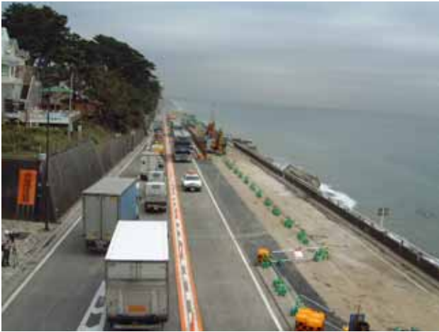
写真-5 暫定 2 車線供用状況
