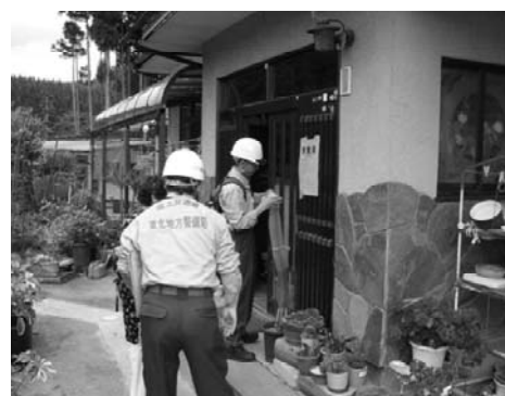
写真-5 被害建築物調査 調査状況
