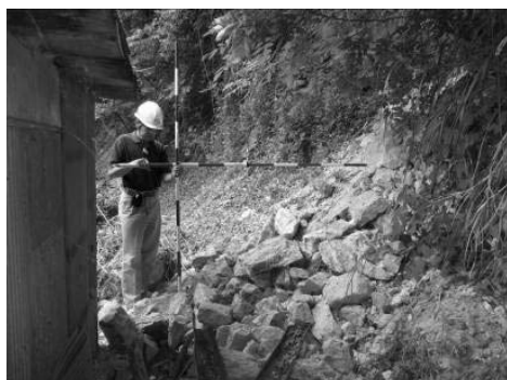
写真-3 土砂災害危険箇所 調査状況
