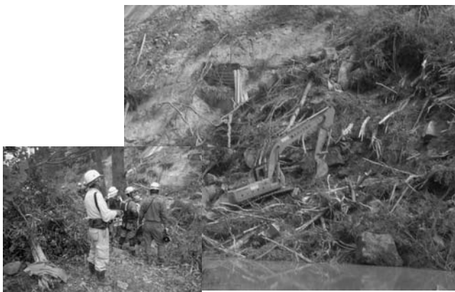
写真-9 遠隔バックホウ 稼働状況（栗原市）
