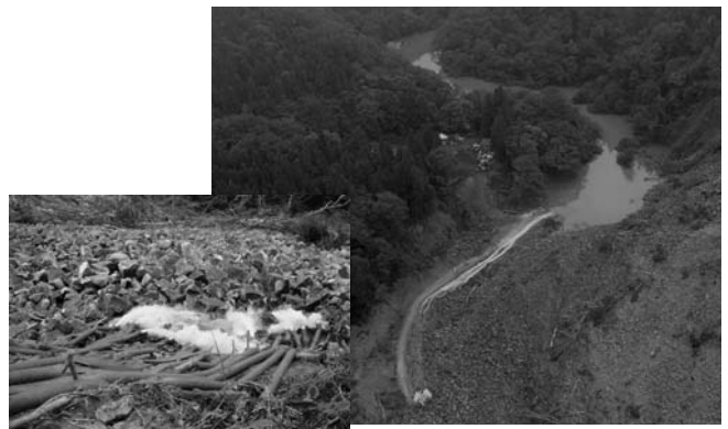
写真-10 排水ポンプ車 稼働状況（湯ノ倉温泉地区）
