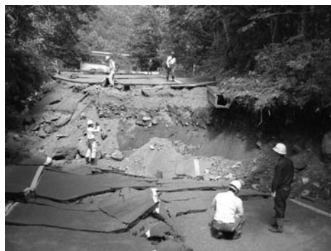
写真-4 土砂災害危険箇所 調査状況
