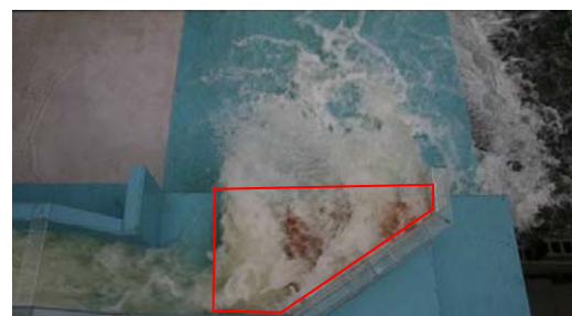
写真-9 階段ブロック配置後の流況
