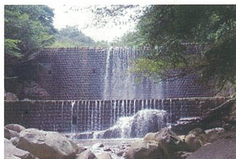
写真-1 登録有形文化財 荒川第6砂防えん堤 [粗石積]
