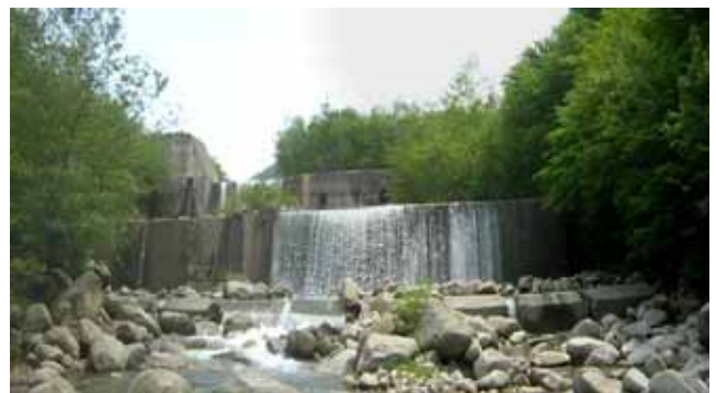
写真-1 小武川第二砂防堰堤
