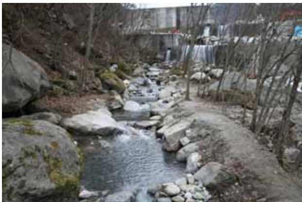
写真-4 完成状況
