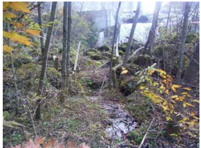
写真-2 整備前の小武川第二砂防堰堤下流右岸
