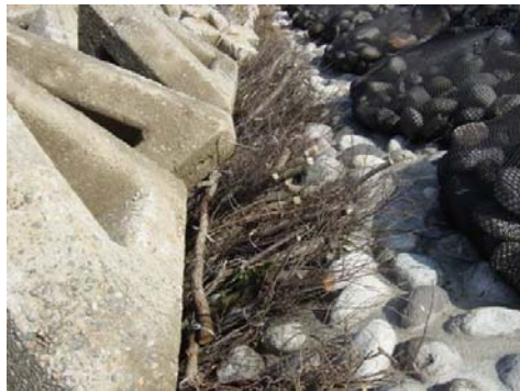
写真-8 試験施工状況 (粗朶敷設部拡大)
