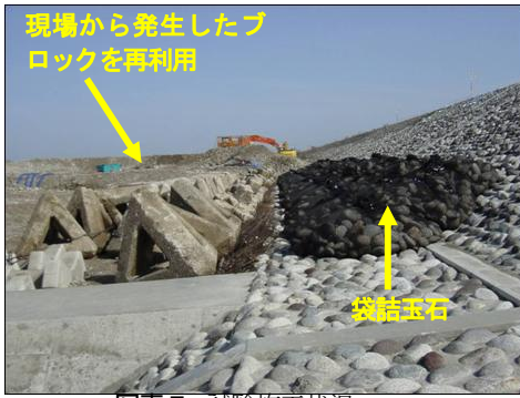
写真-7 試験施工状況
