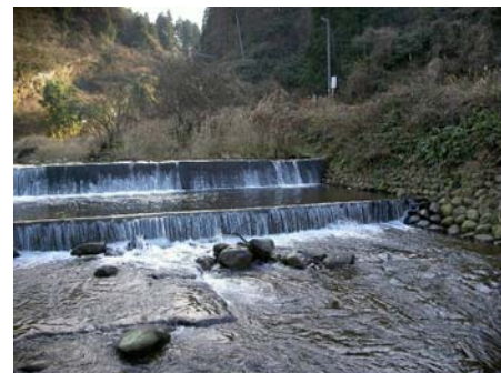
写真-6 魚道整備前の熊野川西小俣取水堰（神通川合流点から約20km上流） 魚道がなく、また堰の落差が大きい。水たき部の水深が浅いため遡上が困難
