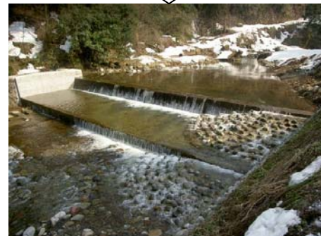
用水管理者の同意が得られ平成20年2月に県、漁協、地域の手で施工。今後、水産関係者によるモニタリングを実施し、本施工の「水辺のこわざ」手法 4) による魚道の効果を検証する。
