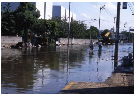
写真-4 平成16年台風16号 高潮被害状況
