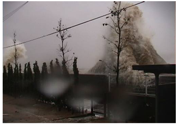
写真-5 平成16年台風23号 越波状況
