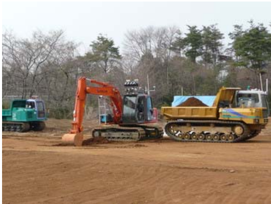
写真 1 掘削積込状況
