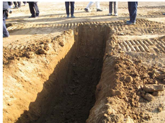
写真 2 溝掘削後の状況
