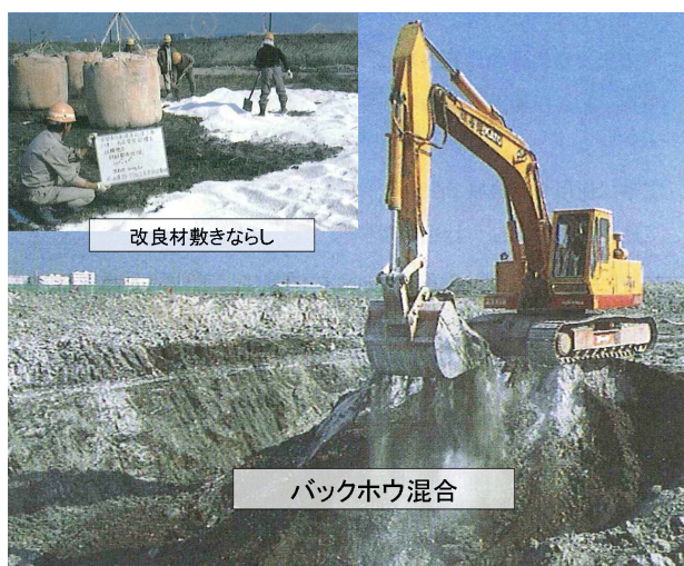
写真-2 1) バックホウ混合と改良材敷き均し状況
