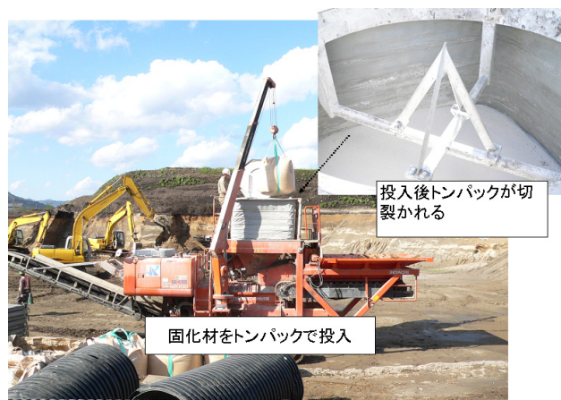
写真-4 固化材の飛散防止対策
