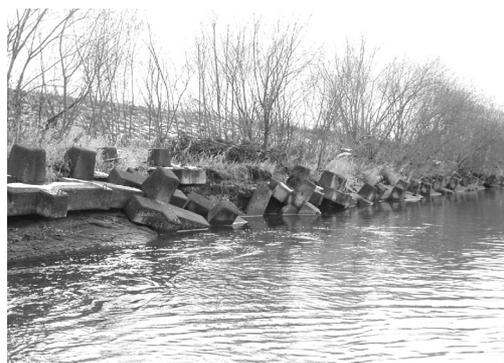
写真-1 洗掘による護岸の浮き上がり
