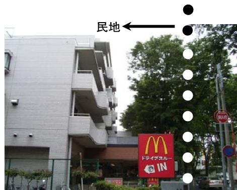
写真-3 越境状況
