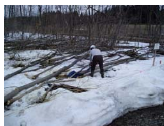
↑写真-11 伐採作業の様子
