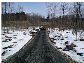
写真-9 進入路の状況
