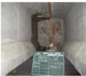
写真-5 塗布状況
