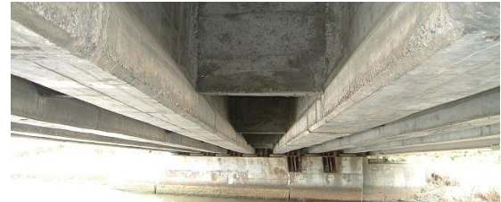
写真-4 試験施工橋の桁の状況
