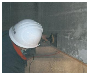
写真-6 測定状況
