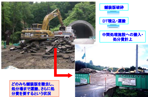
図-2 アスファルト舗装版破碎・積込・運搬・処分状況
