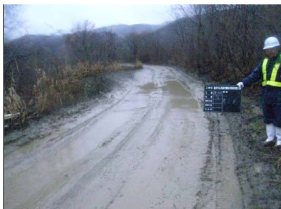
写真-1 現在のダム管理用通路（市道）の管理状況
