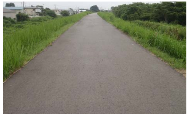
写真-3 切削材利用舗装施工2年後の状況
