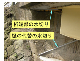
図-11 桁端部の水切り、橋台パラペット部の漏水対策状況
