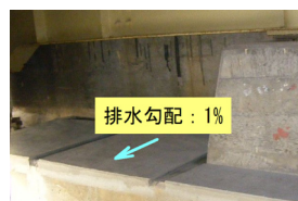
図-12 橋座面の排水勾配
