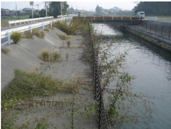
写真-3 コンクリートライニング状況
