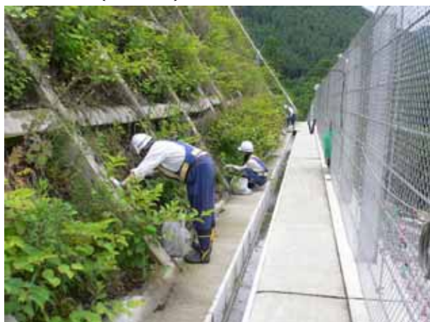
写真-9 急傾斜の法面への移植状況
