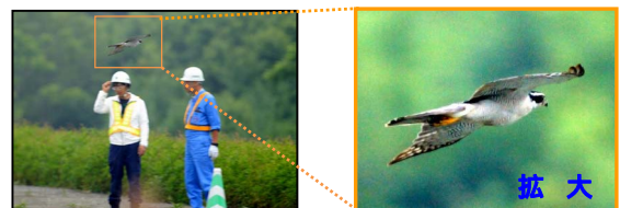
(工事作業員の側を通過して採餌に向かう(手前側で大型重機稼働)) 写真-1 工事実施中の本路線上に出現したオオタカ
