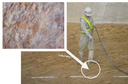
写真－3 岩盤面処理状況
