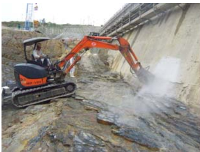
写真－11 コンクリート壁面チッピング状況
