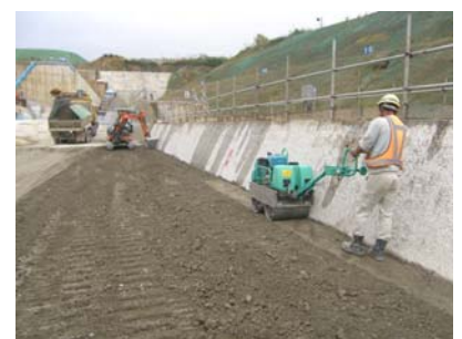
写真－13 コンクリート接合面施工状況
