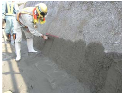
写真－12 コンクリート面モルタル塗布状況
