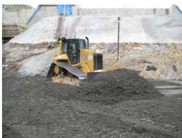
写真－5 CSG 敷均し状況
