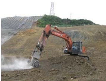
写真－2 基礎掘削状況
