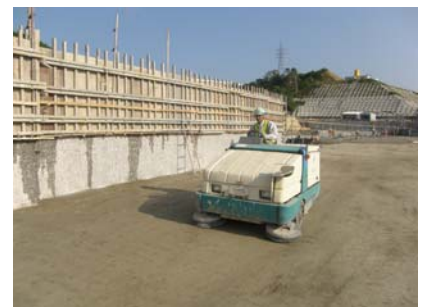
写真－10 CSG 打設面清掃状況
