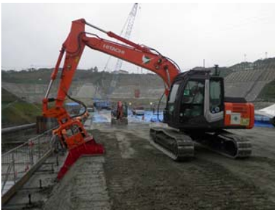
写真－8 CSG 法肩締め状況
