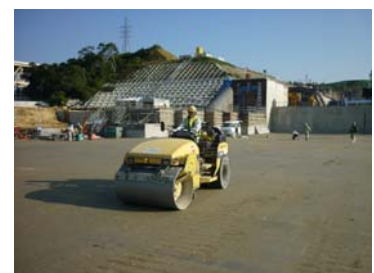
写真－7 仕上げ転圧状況
