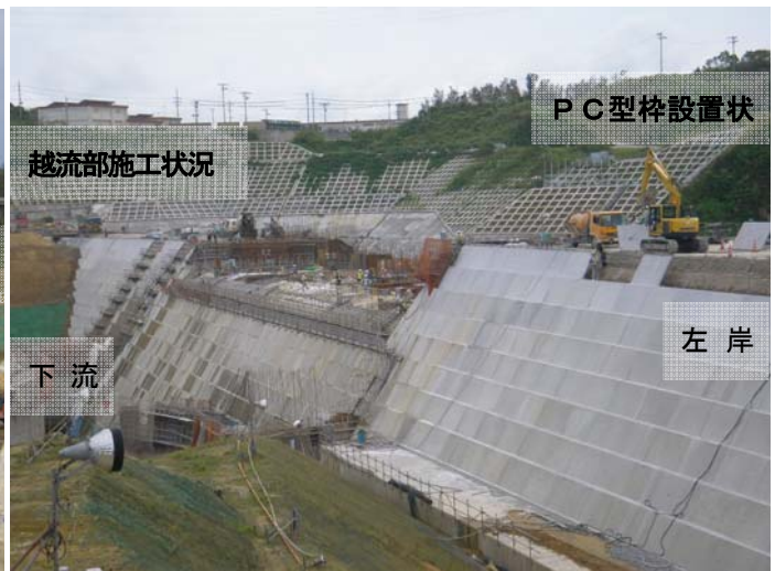
写真-18 左岸下流より上流を望む
