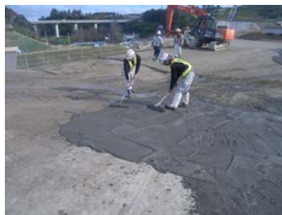
写真－9 CSG 打設面モルタル塗布状況
