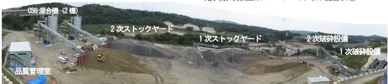
写真－1 仮設備ヤード全景
