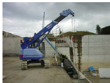
写真－15 P C 型枠設置状況
