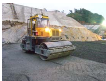
写真－6 CSG 転圧状況
