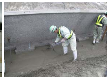
写真－16 P C 型枠底盤モルタル充填状況
