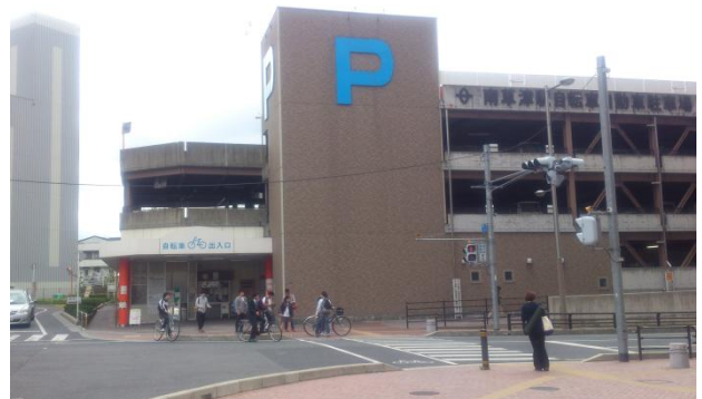
写真-1 南草津駅自転車自動車駐輪場
